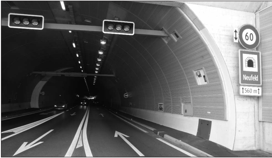
Neufeldtunnel: Seit August 2009 in Betrieb.
