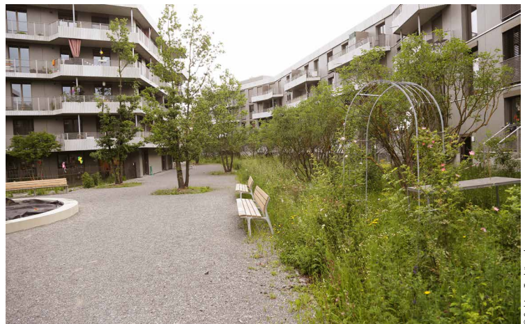
Auch auf Privatgrund ist vieles möglich: Innovativer Neubau mit entsiegelten Wegen im Stöckacher, Bern
